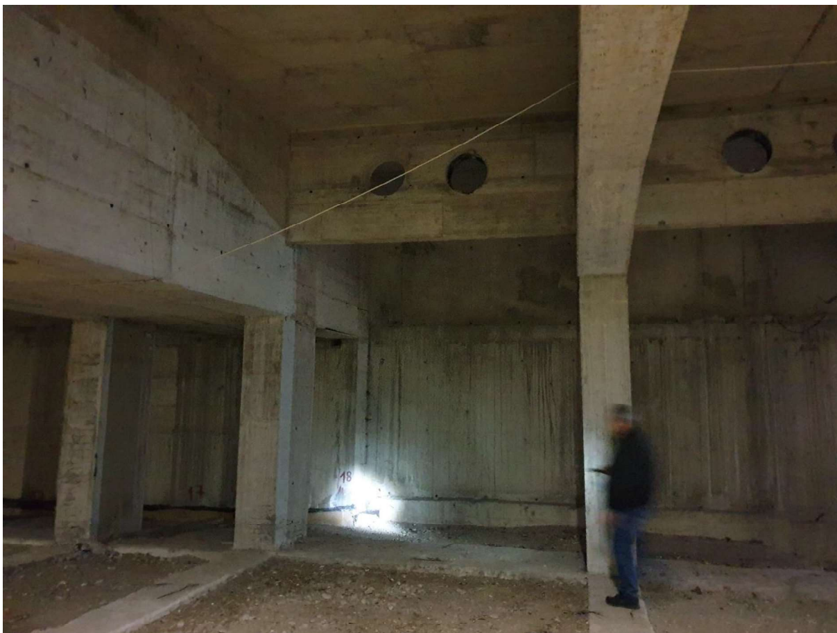
Betonska kineta, ki prečno preseka dvoranski prostor
