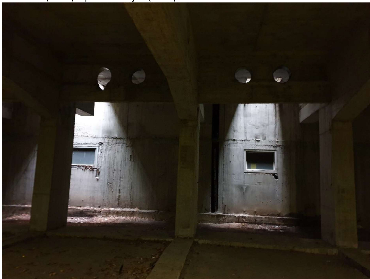
Prečni in vzdolžni AB nosilci, v ozadju stena stanovanjskega kareja
